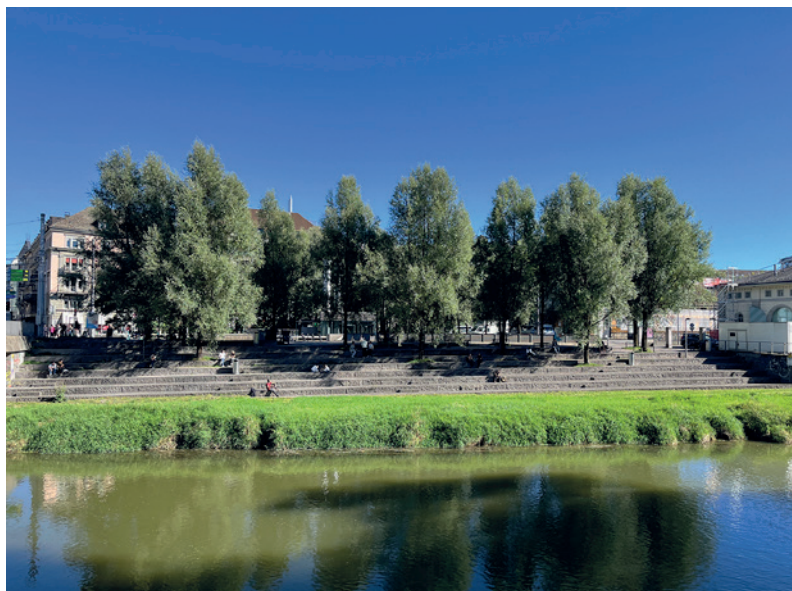
Fig. 1. L'aménagement de gradins facilite l'accès aux berges.
